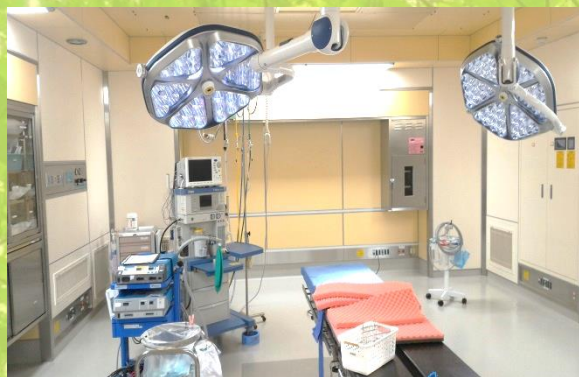
➤ 手術室 内装空調施工
