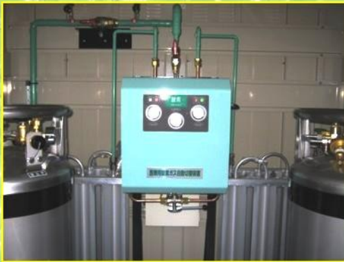
➤ 医療ガス設備施工
